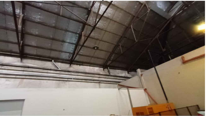
CANALETAS Y CAÑOS DE DESAGUE SOBRE CONSTRUCCION EN SECO
