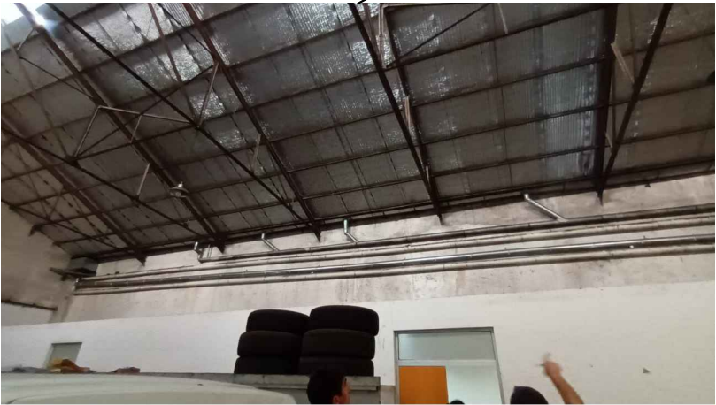
DESAGUE PLUVIAL SOBRE LA MEDIANERA
